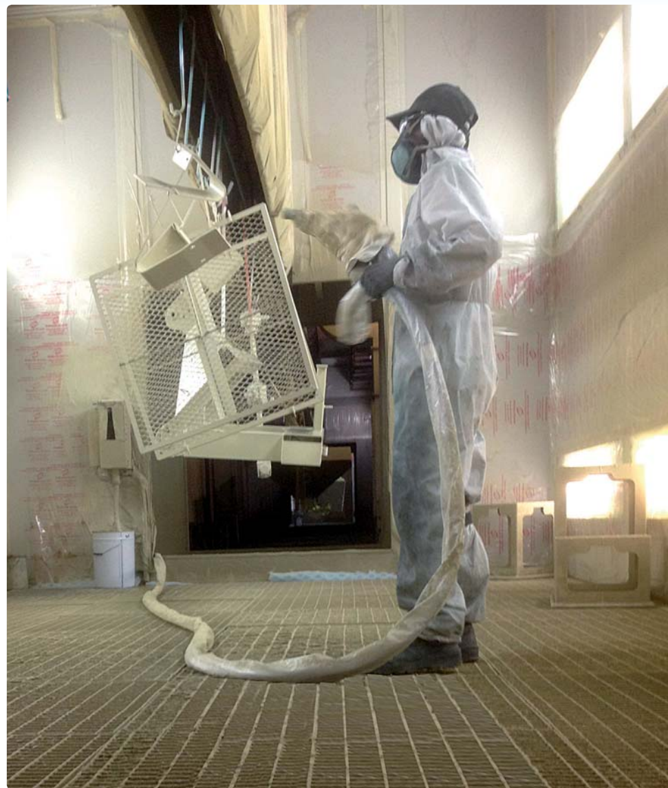
Второ анти-корозионно покритие и завършващо покритие
